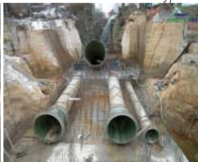
Průkop hráze s novým potrubím přetokové výpusti a spodních výpustí
