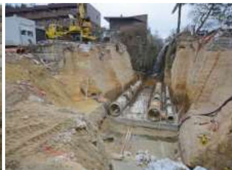
Průkop hráze s novým potrubím přetokové výpusti a spodních výpustí
