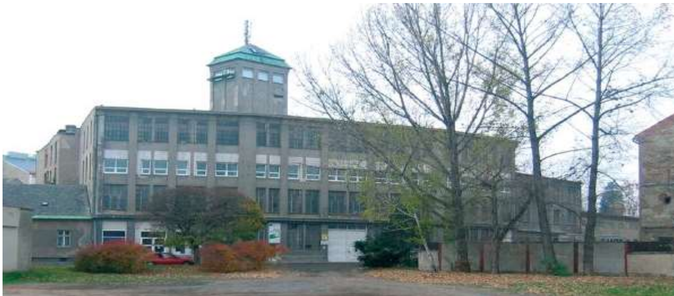
Starý stav budovy barvírny
