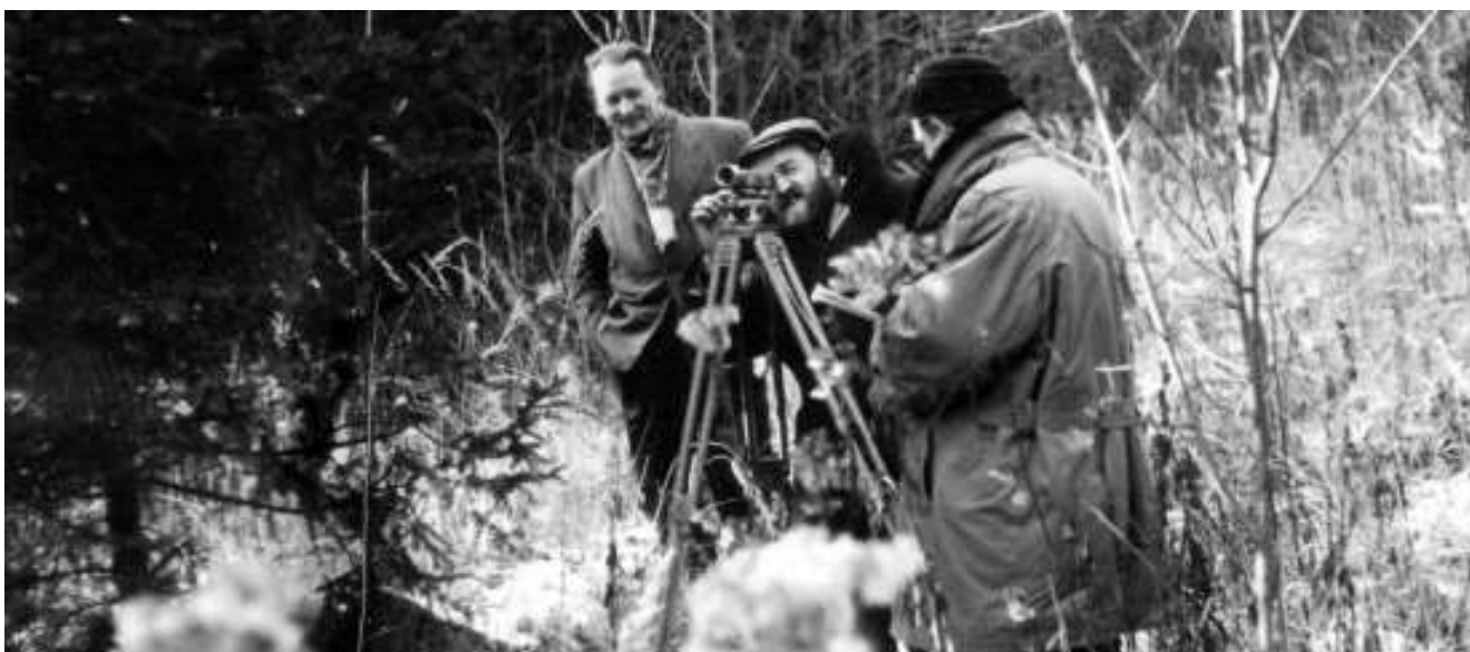
Zaměřování budoucího staveniště vlevo František Synek z nedaleké Olešné, stavbyvedoucí přehrady.
