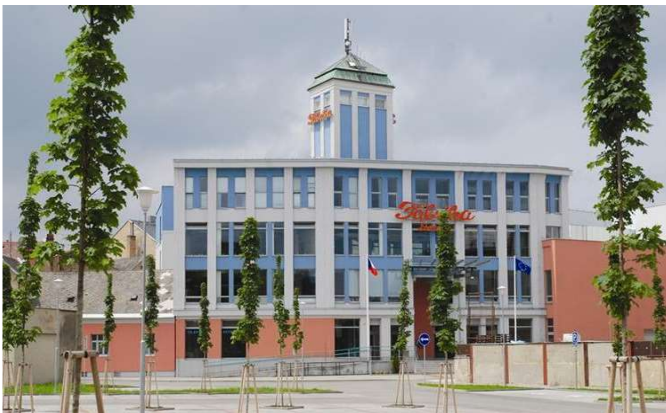
Budova po konverzi a rekonstrukci
