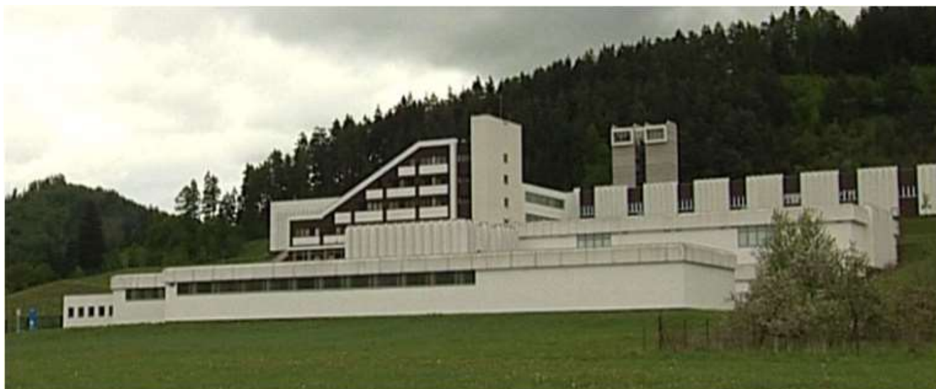
Úpravna vody z vírské přehrady pro Brno Švařec
