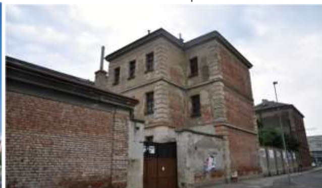
a zezadu ruina staré věznice
