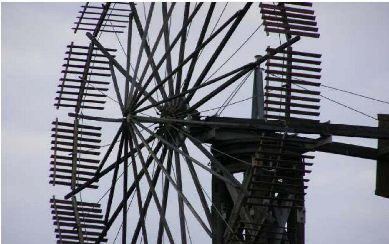
Detail Halladayova rotoru v Ruprechtově
