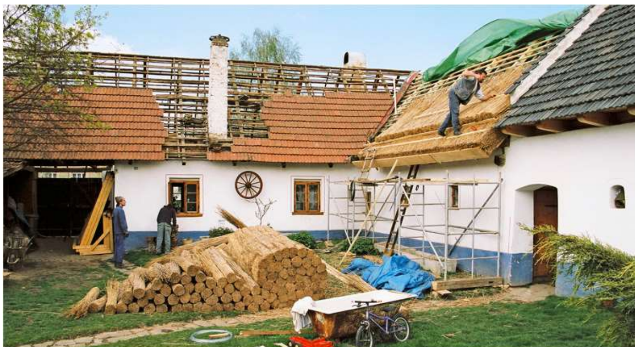
Realizace doškové střechy
