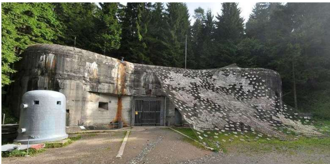
Tvrz Bouda, objekt K- S22a
