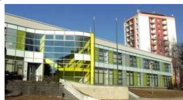
Nově opravený kulturní dům
