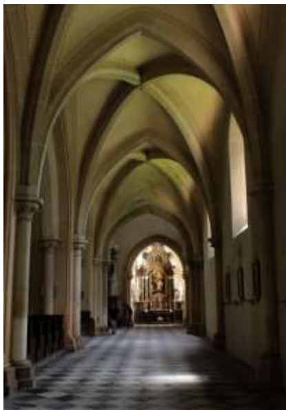
Gotická křížová chodba kláštera
