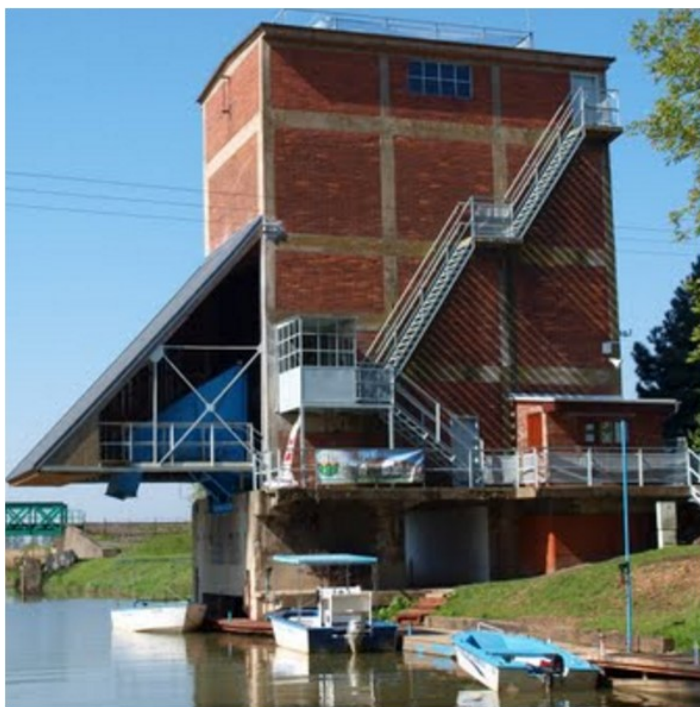
Pohled na výklopník
