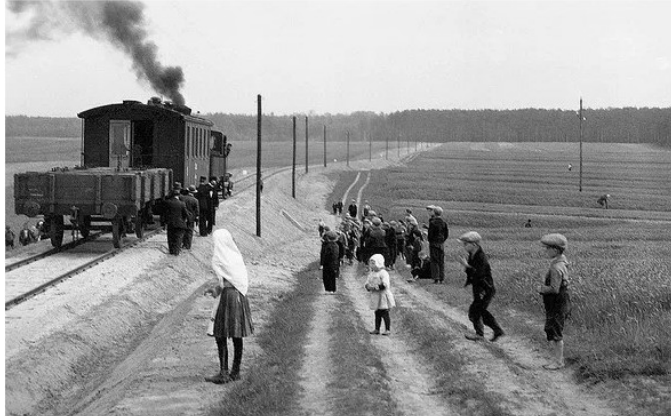
Železniční vlečka, nově zbudovaná, do Rohatce
