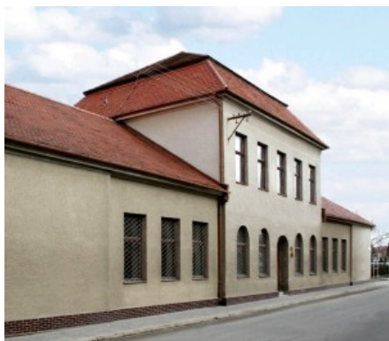
Budova Stredoeurópskej vysokej školy
