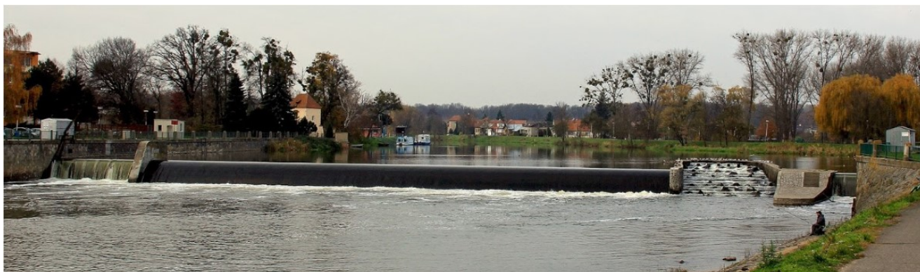
Splav na Dyji s rybochodem a podzemní hydroelektrárnou
