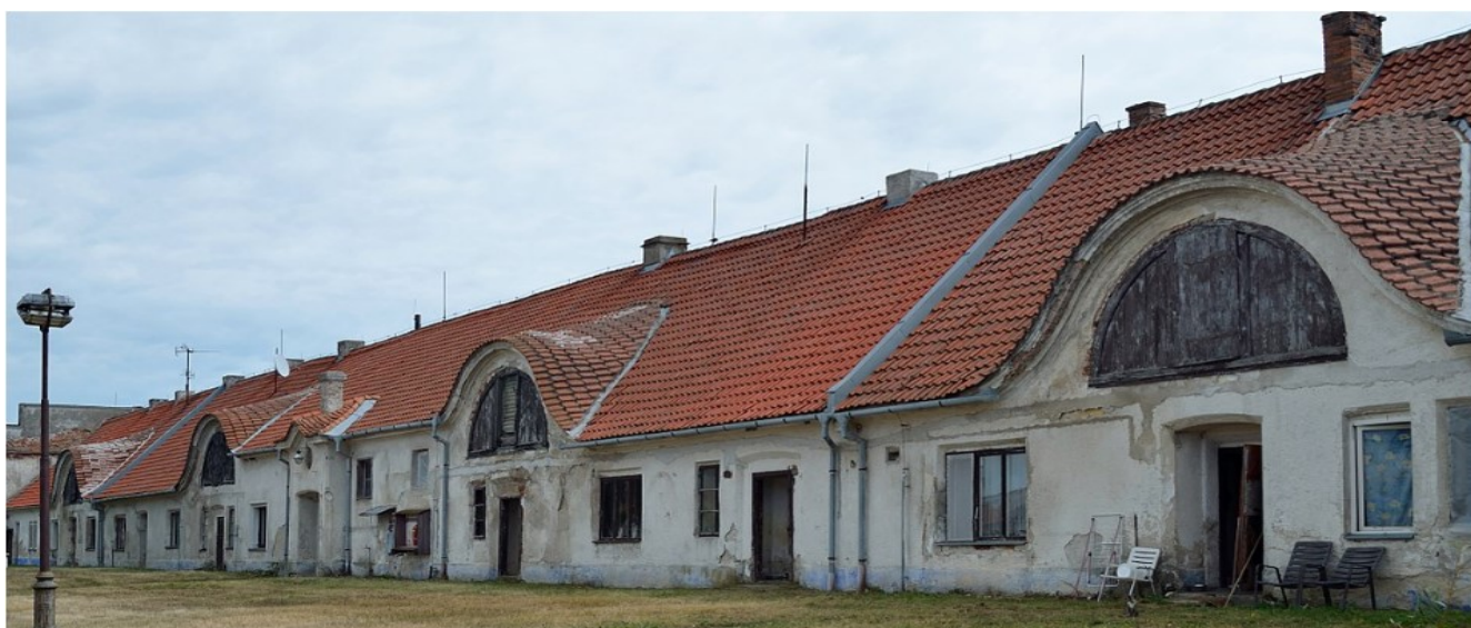
V jihovýchodním křídle byly byty
