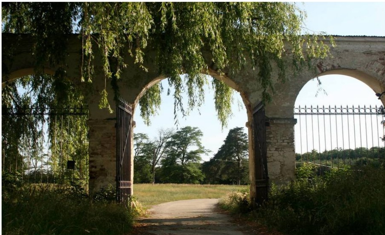
Široká brána s trojicí valeně zaklenutých otvorů s vjezdem ve střední ose.
