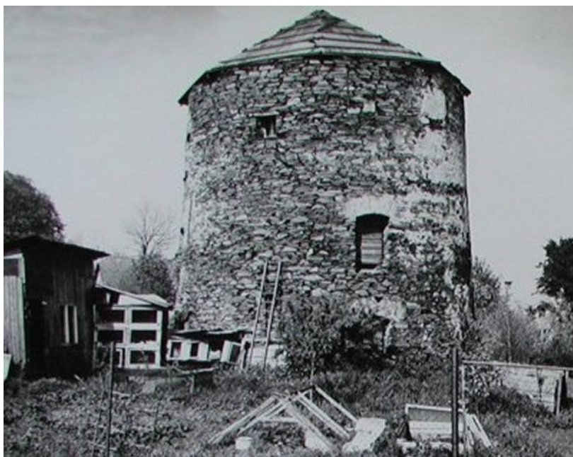
Havarijní stav mlýna na Libavé
