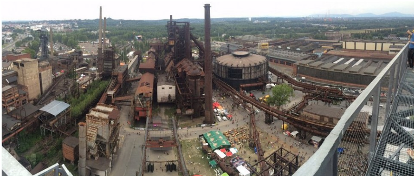
Pohled z věže Bolt Tower na průmyslový komplex
