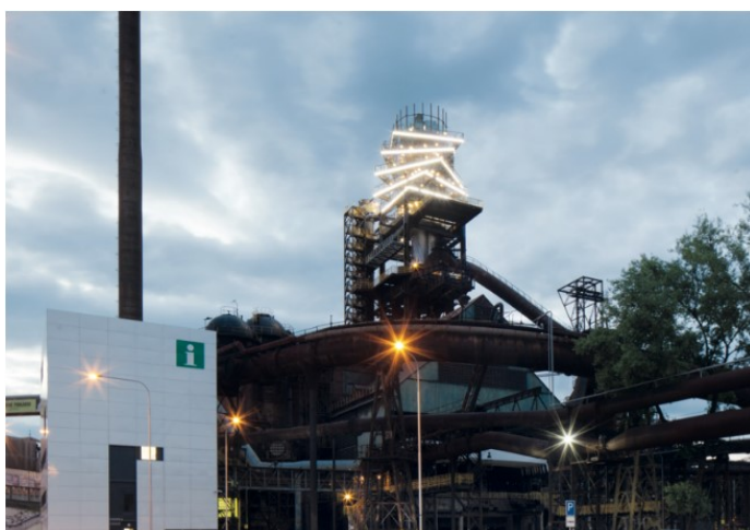
Pohled na věž Bolt Tower na průmyslový komplex
