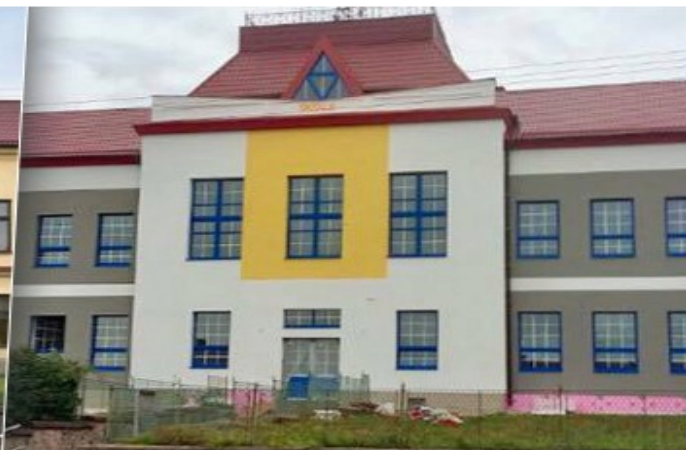
nový stav po „rekonstrukci“
