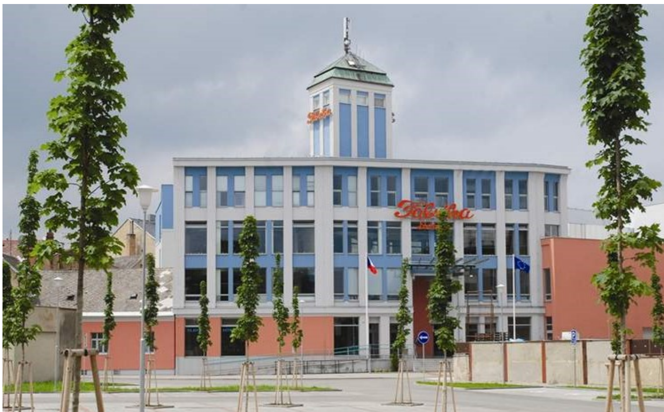
Budova po konverzi a rekonstrukci
