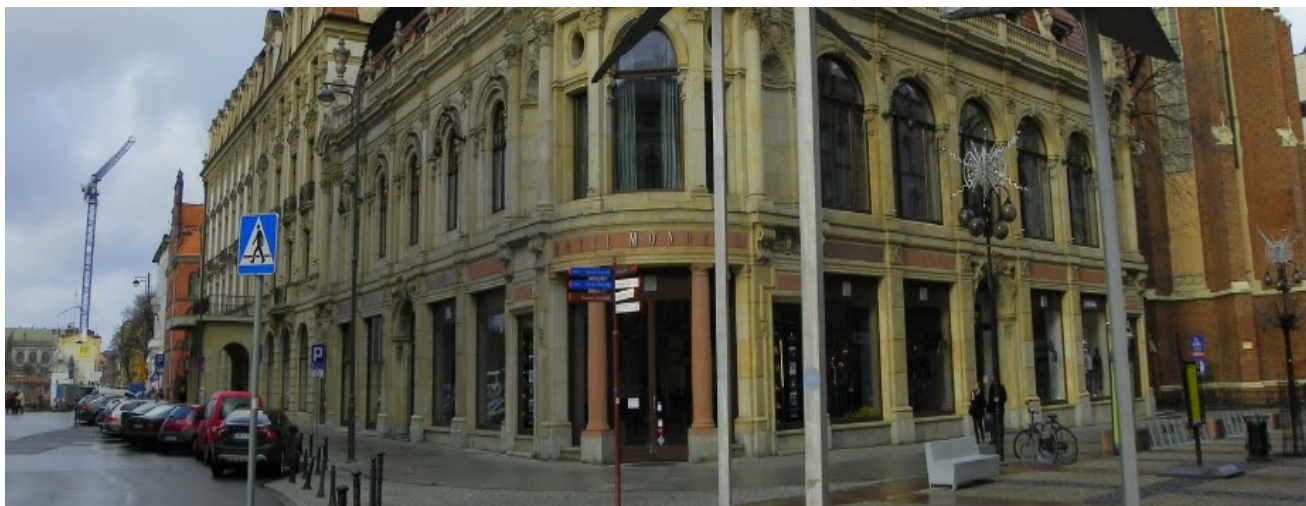
Balkón hotelu Monopol je vlevo ve směru značky přechodu pro chodce.
