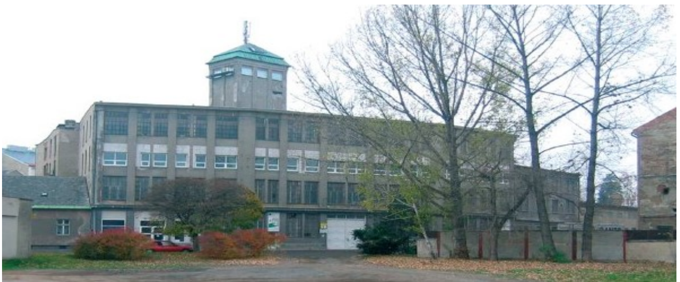
Starý stav budovy barvírny
