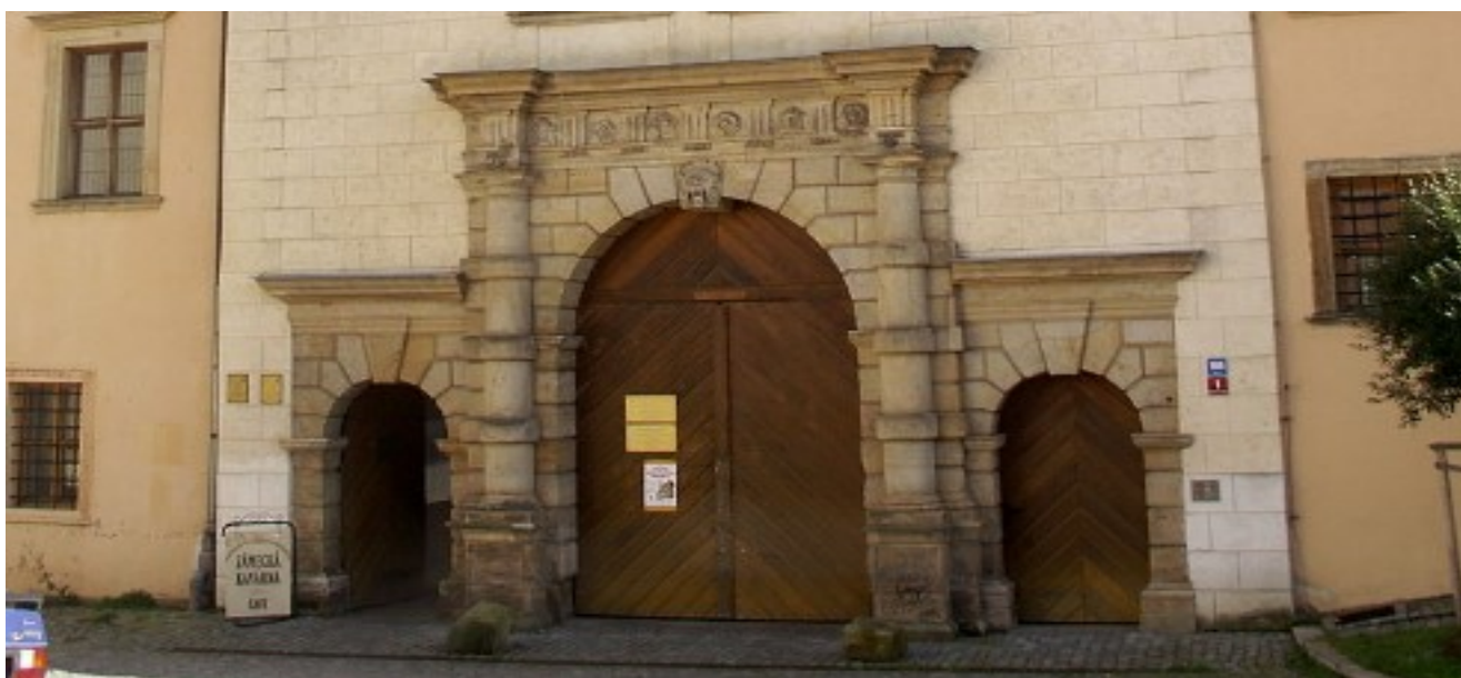
Nádvoří a bosáže portálu zámku
