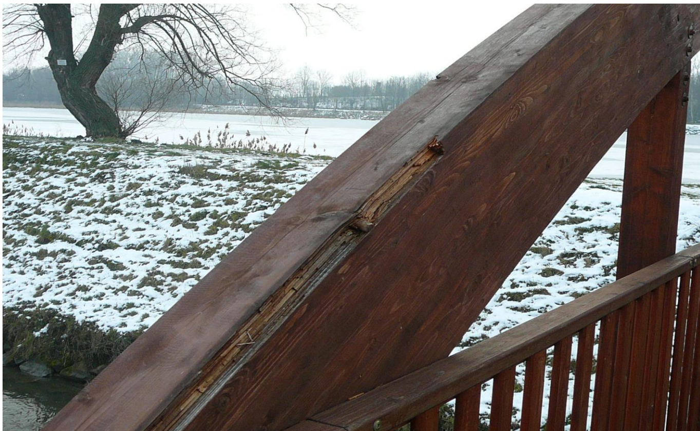
OPLECHOVÁNÍ NOSNÝCH OBLOUKŮ PO OPRAVĚ DŘEVĚNNÝCH LAMEL
