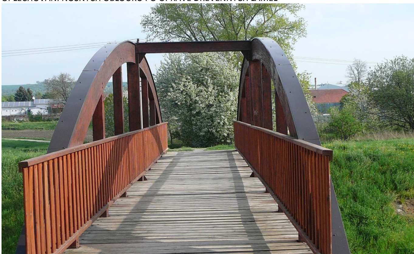
OPLECHOVÁNÍ NOSNÝCH OBLOUKŮ PO OPRAVĚ DŘEVĚNNÝCH LAMEL
