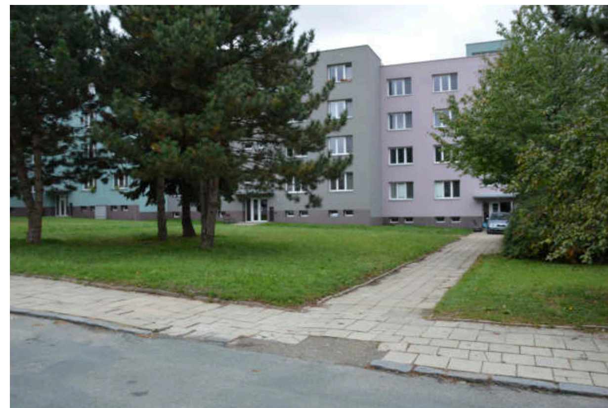
Hlavní prostranství před panelovými domy je poněkud nevybavené.
