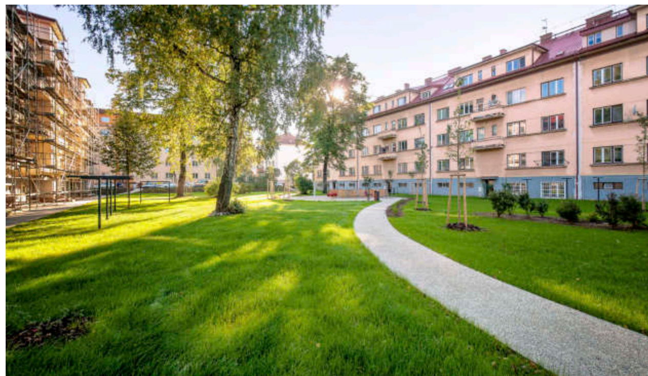
Chodníčky uvnitř vnitrobloku nemusí být široké. Zde provedení z vymývaného betonu.
