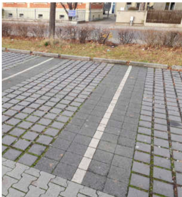
Praktické využití různých druhů dlažby pro parkovací místa slouží pro vsak srážkových vod, trvaně vodorovné dopravní značení a bezpečný nástup do vozidla.
