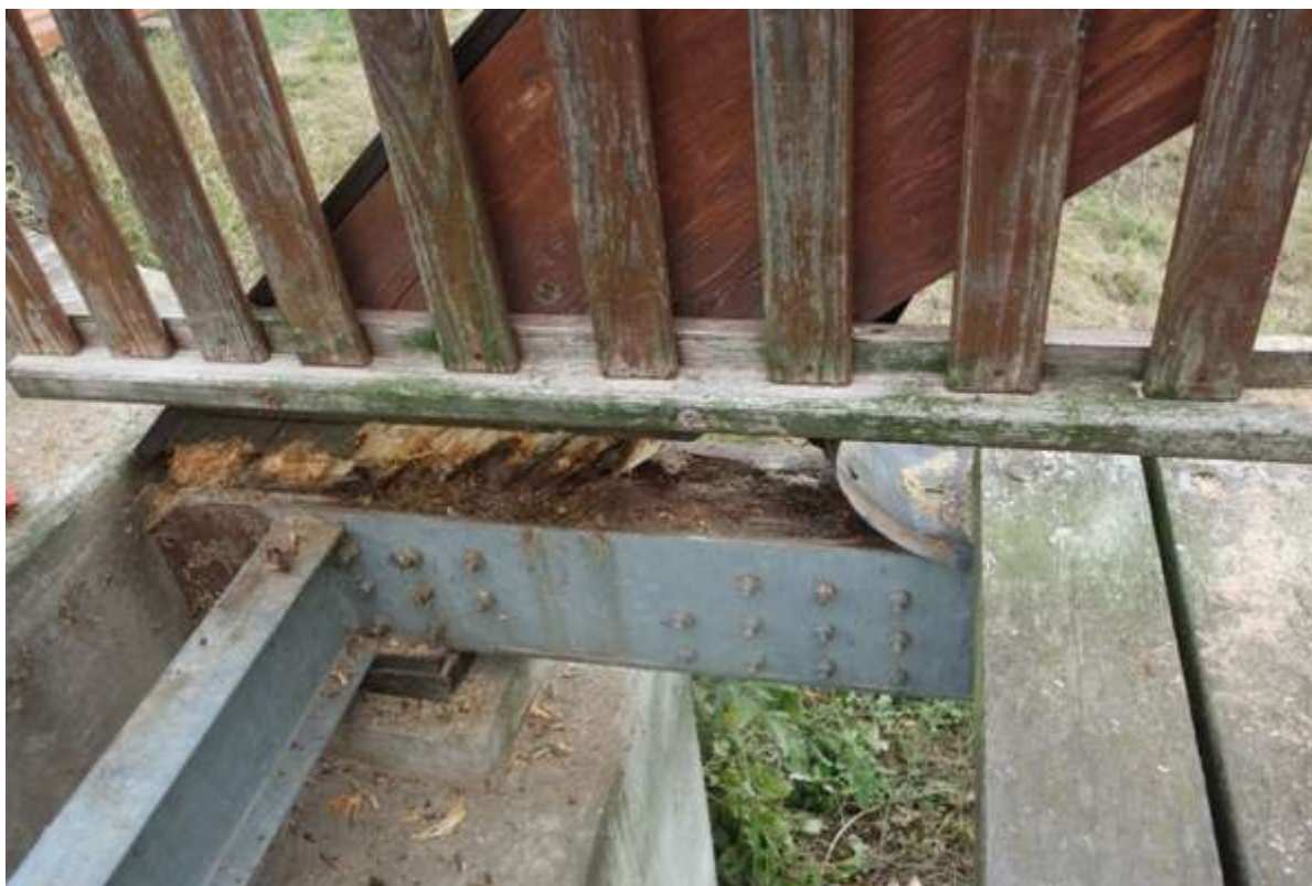
Oprava uhnílého nosného oblouku mostní konstrukce lávek přes Litavu. Tento stav na třech mostech.
