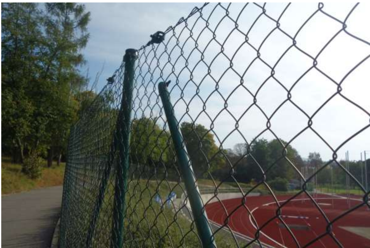
Ujíždějící svah trhá nosnou konstrukci oplocení areálu stadionu.
