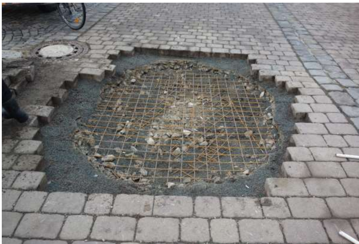
Oprava propadající komunikace na náměstí před pekárnou Herold. Neznámá příčina pravidelného propadu. V minulosti byla v těchto místech na náměstí studna. Zahutněno, vyztuženo kari sítí, zabetonováno a zpět zadrážďeno.
