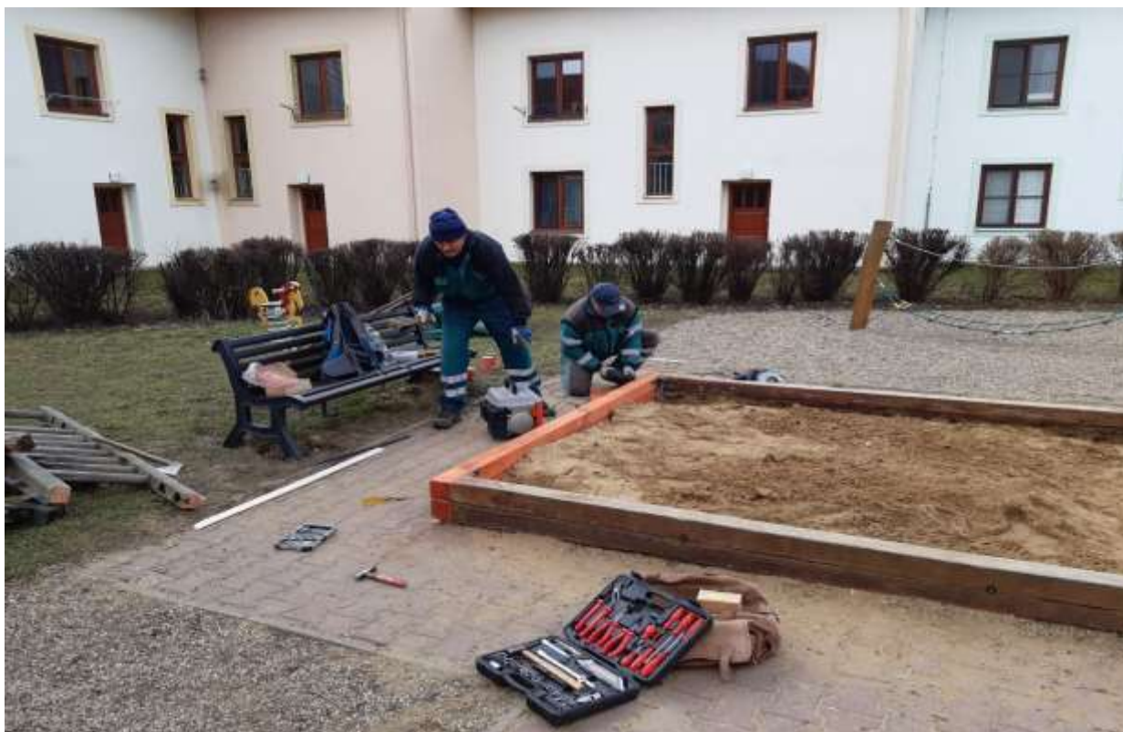
Oprava rámu pískoviště s instalací nové krycí plachty včetně opravy herních prvků v sídlišti Litavská.
