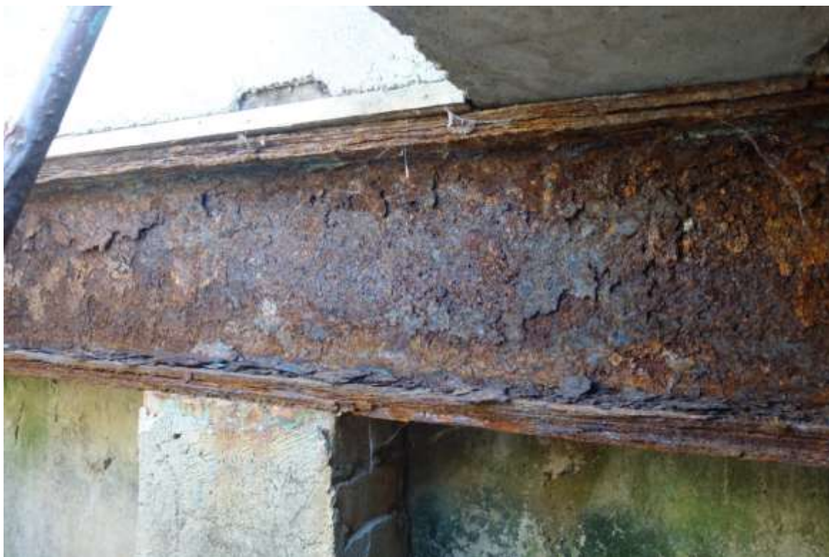
Nosná konstrukce pochůzných ploch kolem tělesa velkého plaveckého bazénu na koupališti.
