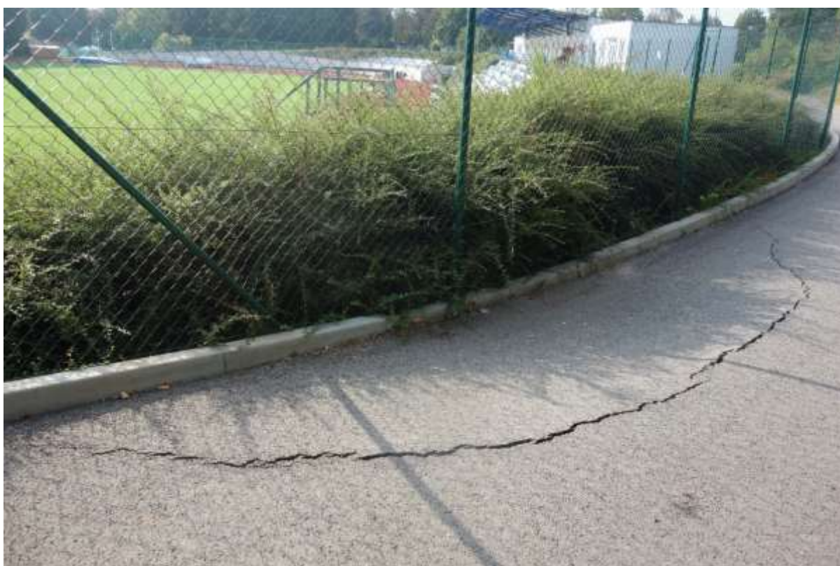
Ujíždějící svah severní strany stadionu s důsledkem trhání a propadání asfaltové komunikace.
