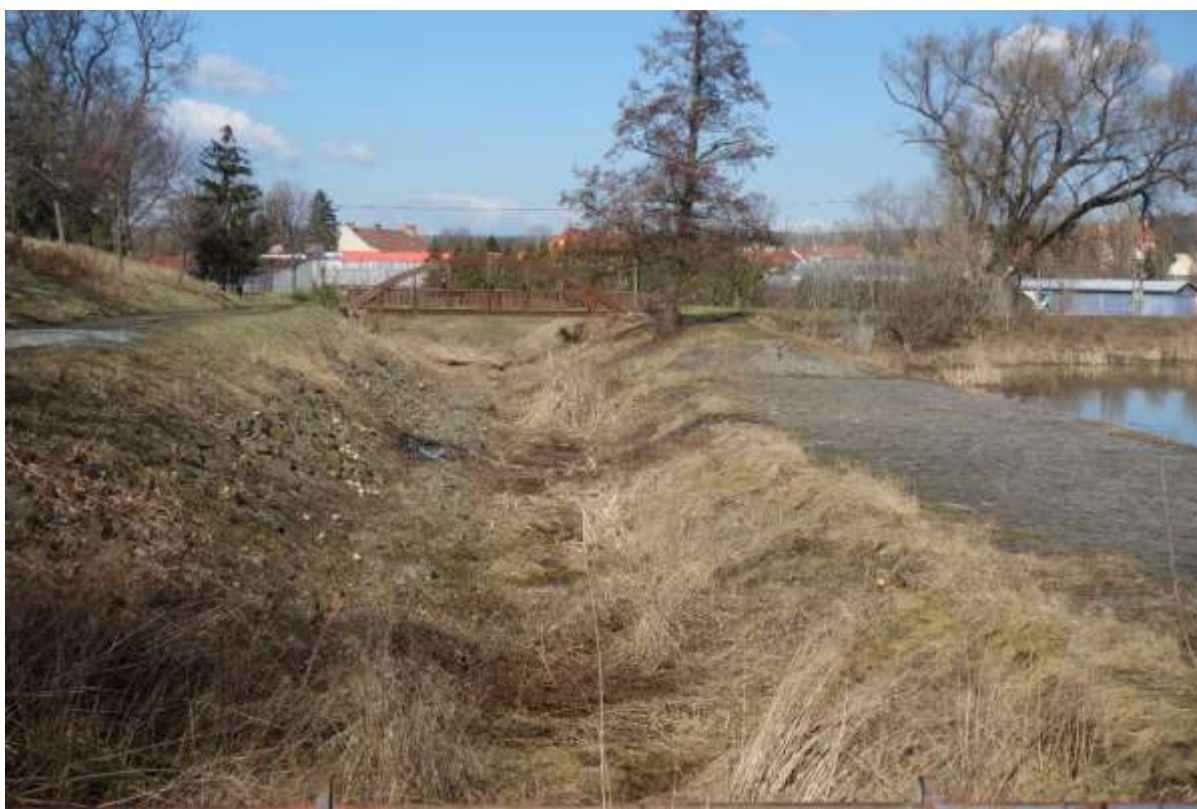
Vyčistění náletových dřevin u koryta přepadu velkého rybníku.
