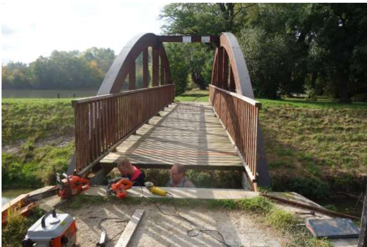
Oprava mostu přes Litavu a výměna pochůzných mostnic před první revizí.
