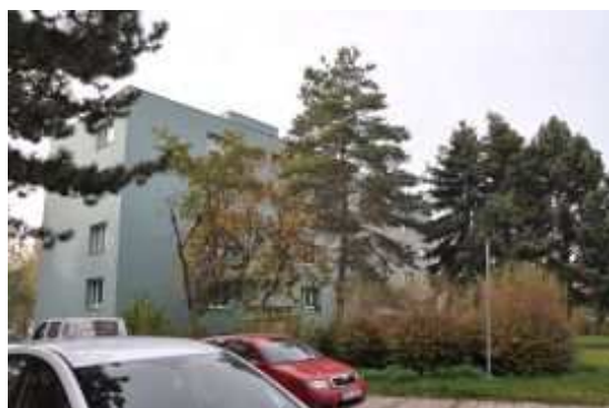
Trojblok domů na sídlišti Nádražní
