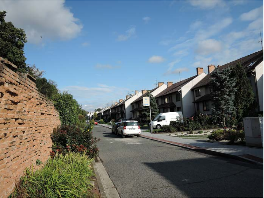
Obr. 6: KO 4: Jednotná zástavba podél části jižní ohradní zdi zámecké zahrady.
