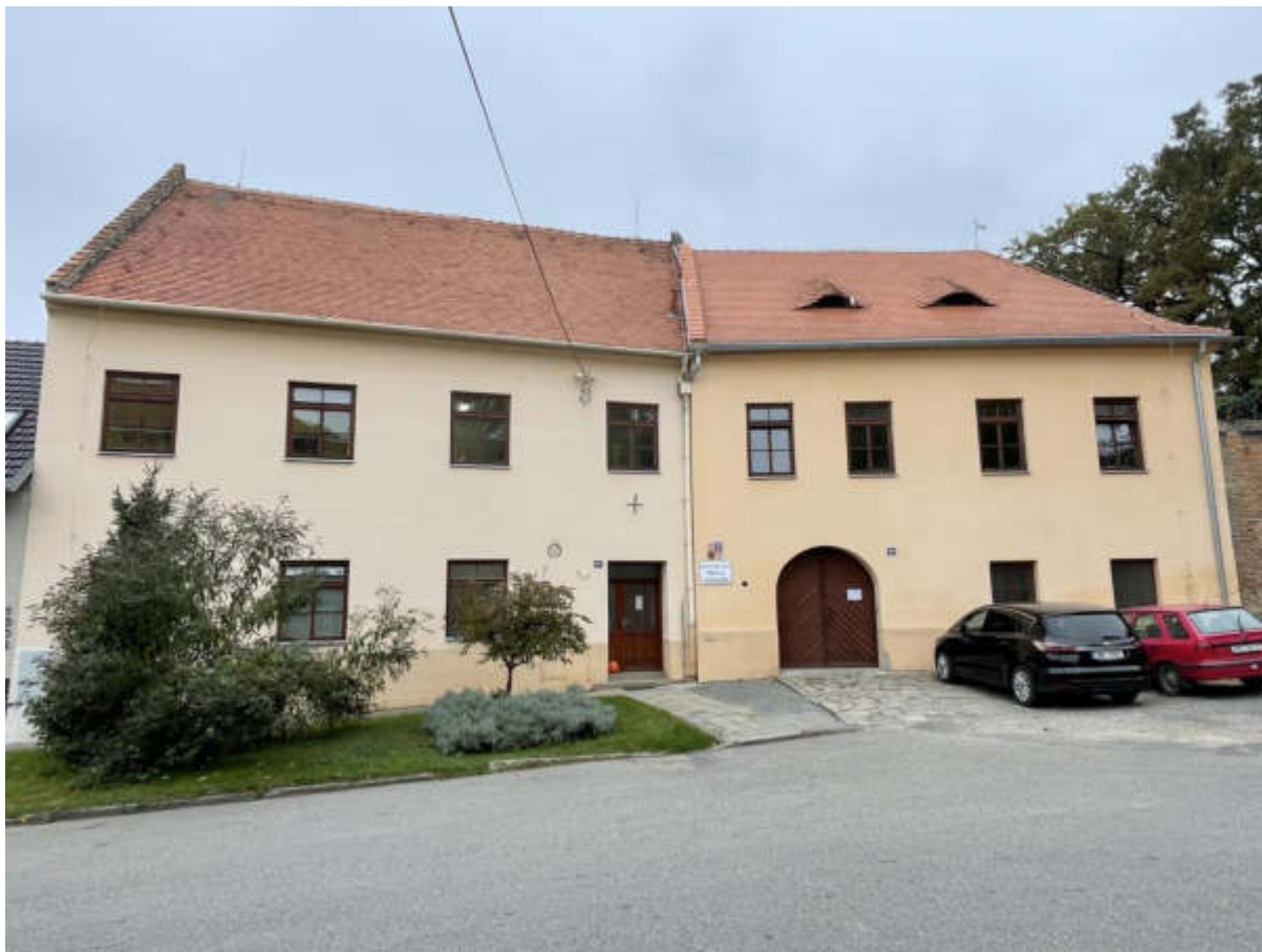
Obrázek 7: Mateřská škola a bytový dům 107, 108
