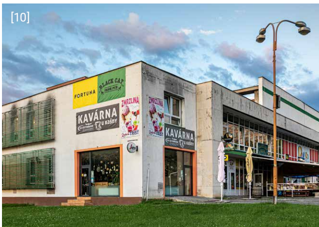
✗ Opakující se sdělení zaplňuje téměř celou plochu nad provozovnou, takže zaniká. Na použitých materiálech také záleží.
